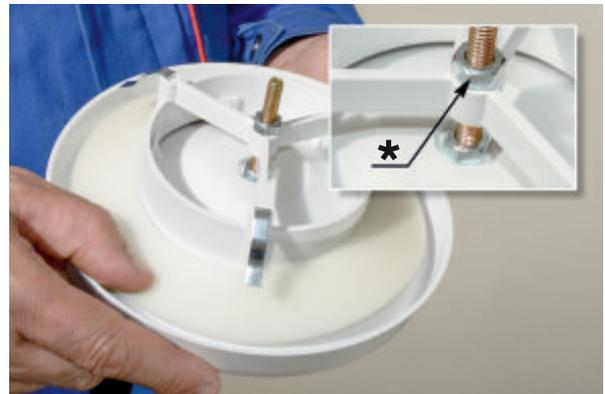
4) Nach dem Einstellen des erforderlichen Luftstroms demontieren Sie das Ventil durch sein Herausziehen, wobei die Zentralscheibe mithilfe einer Kontermutter zu arretieren ist.
