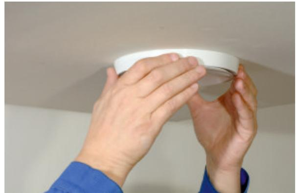
2) Schieben Sie das Ventil zur Decken-/Wandkonstruktion bis zum Anschlag ein.
