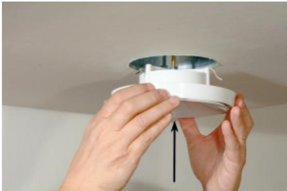
1) Drücken Sie das Kunststoff-Tellerventil in den verankerten Auslass des Lüftungssystems.
