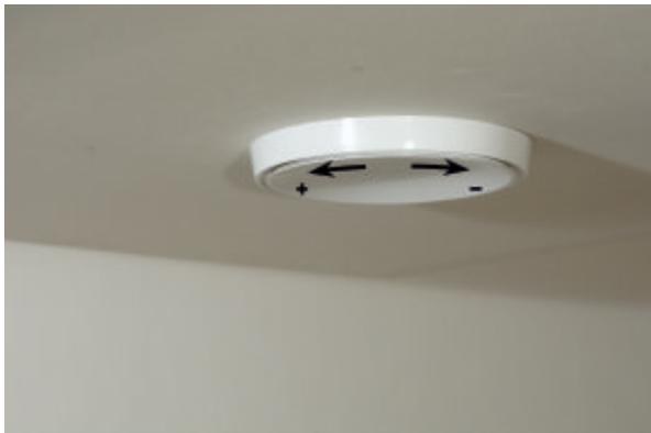
3) Der Luftstrom wird durch Drehen der zentralen Scheibe reguliert, wodurch die Öffnung des Ventils geändert wird.
